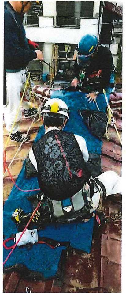
被災した家屋の屋根にブルーシートを張るメンバーら(9月28日、木更津市で)＝「愛・知・人」提供
